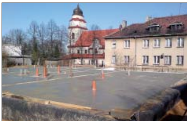
Trwa budowa nowej Przychodni Zdrowia w Wyrach – czyt. na str. 11.
